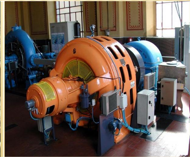
*Alternatore di centrale idroelettrica*
